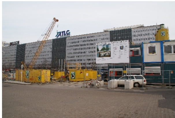
改修中の広場の一角
