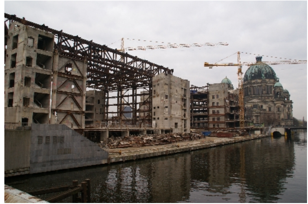
解体中の共和国宮殿
