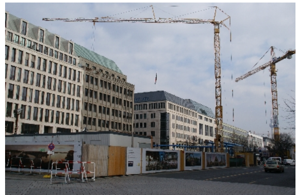
地下鉄の工事現場
