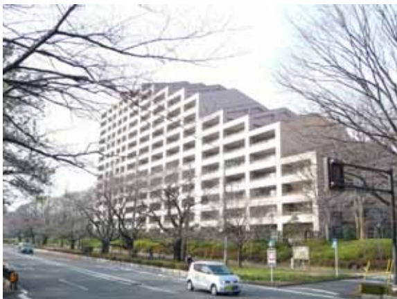
写真2 マンションの景観（大学通り側） 撮影：2010年2月10日
