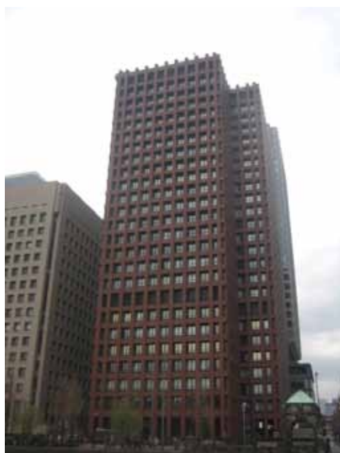
写真2 現在の東京海上ビル（2009/12/24撮影）
