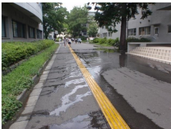
H27 総合・人文 1 号館付近での漏水事故
