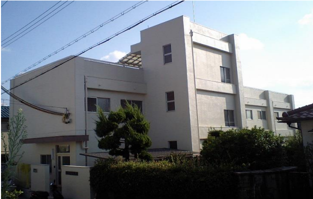
(平成28年7月寮外壁改修工事実施)
