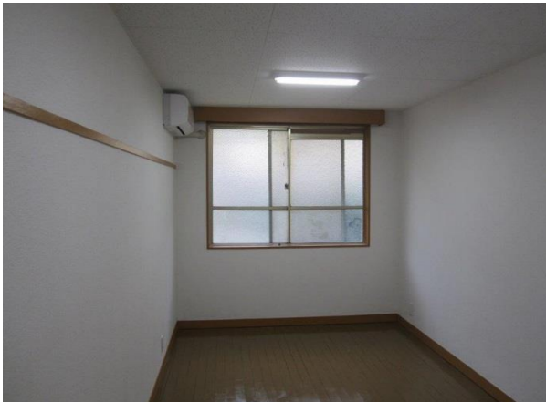
(平成26年3月寮生個室改修工事実施)
