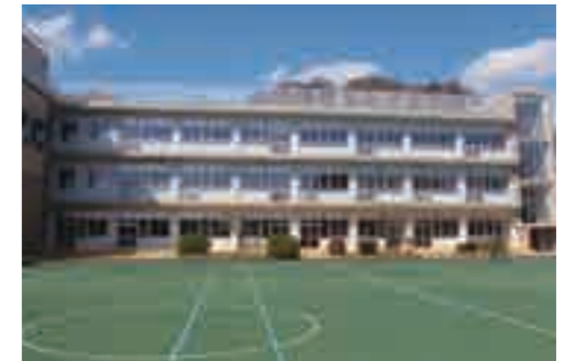
完成後(外壁断熱材設置 二重硝子)
