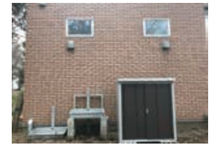
若草研究室に設置された水道と倉庫
