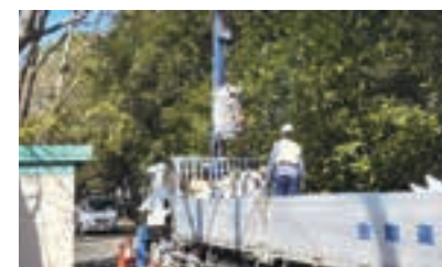
低濃度PCB廃棄物搬出の様子
