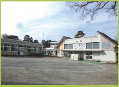
附属幼稚園小金井園舎
